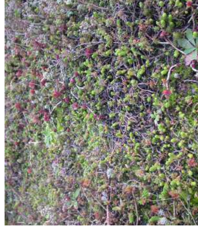
Toit végétalisé sur une maison d'habitation contemporaine.
