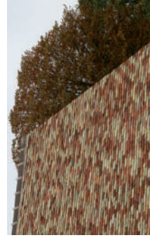
Toiture chamarrée par le mélange des tuiles
