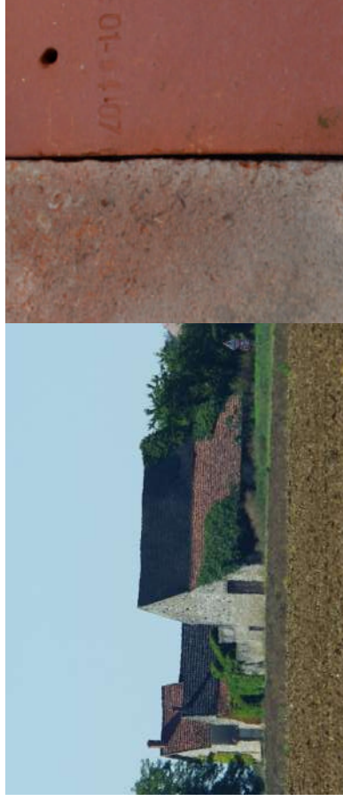
Les tuiles peïfites, moulées, sont caractéristiques des toitures du Gâtinais français.
